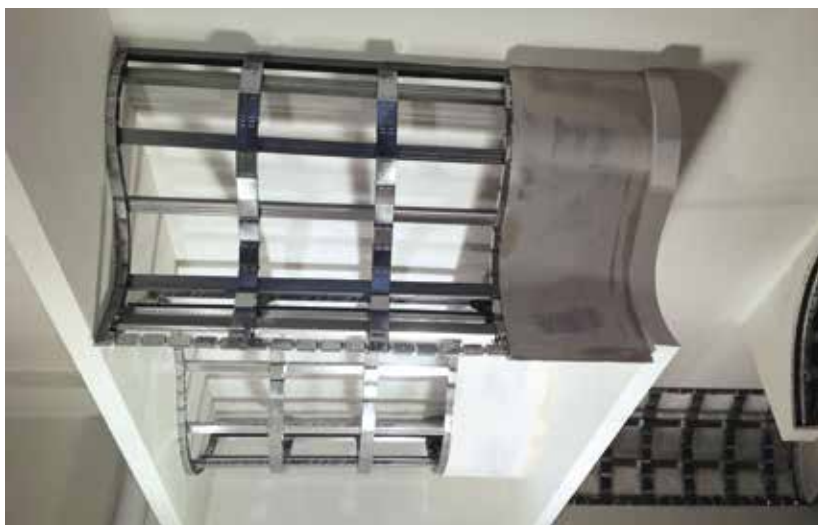
Beispiel der Ausführung einer welle decke.
